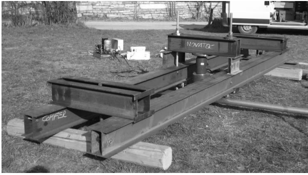
Figura 8. Sistema di contrasto per l'esecuzione delle prove di compressione in assenza di fondazione superficiale, nel sito-campione di Bosco Chiesanuova (VR).
